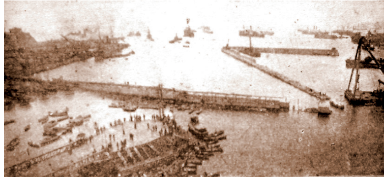
Fig. 6. Los trabajos de construcción del Muelle Prat.
