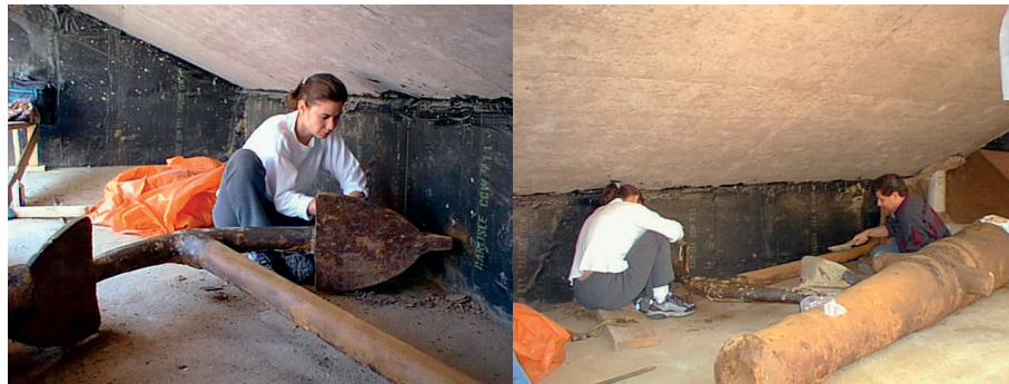
Fig. 39-40. Trabajo de conservación de algunas de las piezas metálicas –ancla y cañón- que se expondrían en el Museo de Sitio de Plaza Sotomayor. También se procedió a conservar los maderos que estaban in situ, como los que se repusieron.
