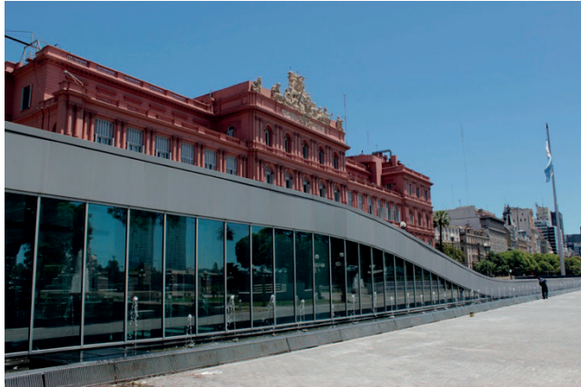
Figura 20: Museo de la casa Rosada en antiguas de la Aduana de Taylor con un espacio superior que permite identificarlo.
