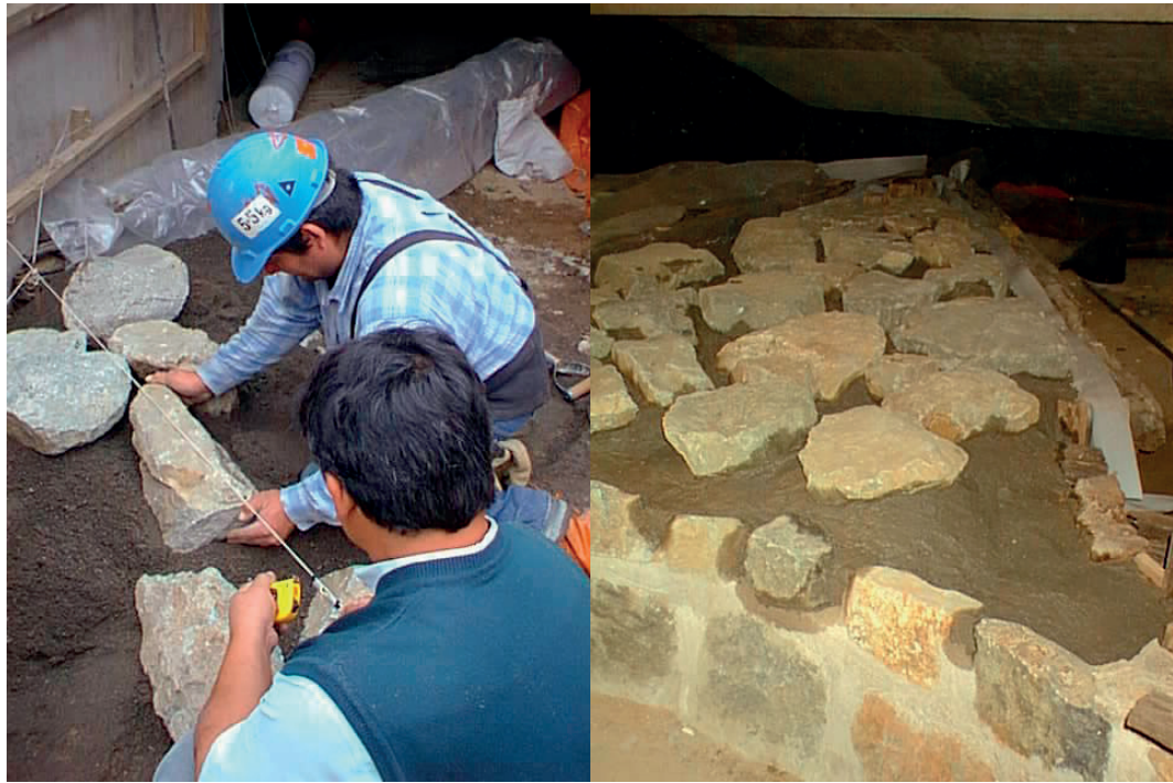
Fig. 57 y 58. Reubicación de las piedras canteadas a partir de los dibujos de planta, sobre una cama de arena y con mezcla de cemento para evitar el desplazamiento de las mismas.
