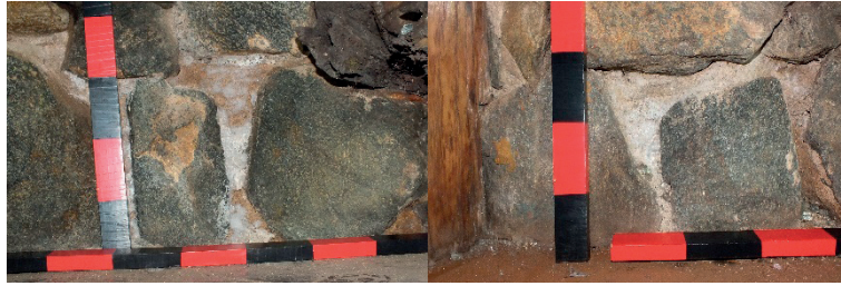
Fig. 71 y 72. Acumulación de cloruros en las piedras canteadas.
