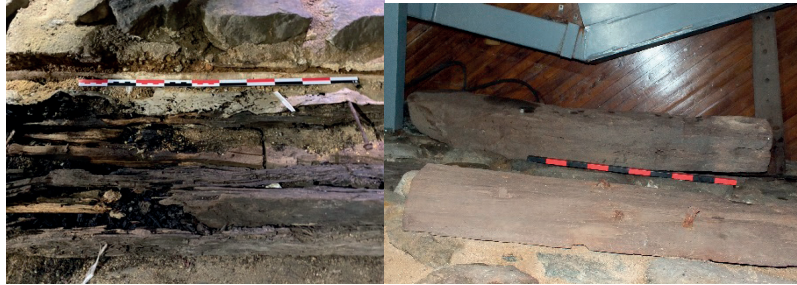
Fig. 82 y 83. Desprendimiento y traslado de piezas de madera.
