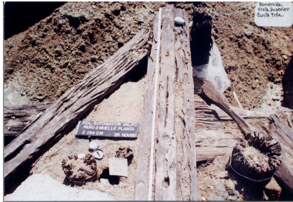
Fig. 28. Detalle de la punta de la cabeza del Primer Muelle de Valparaíso o Muelle Esmeralda.
