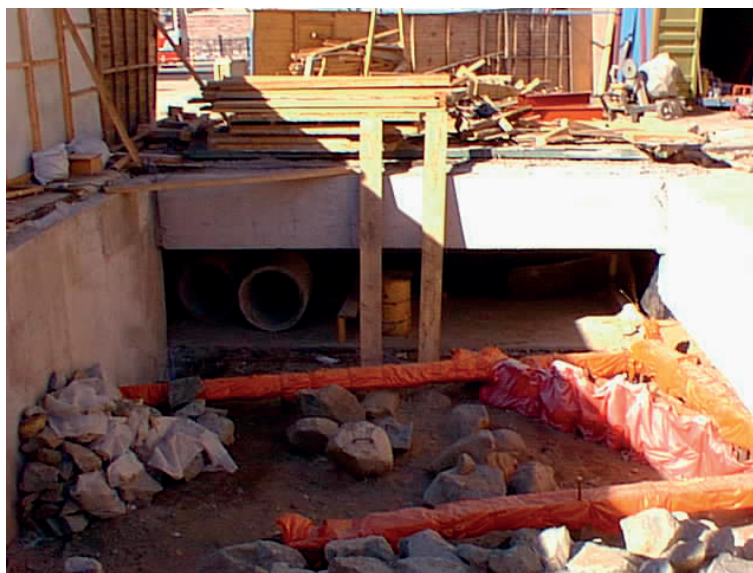
Fig. 34. Estado de avance de los trabajos de construcción del Museo de Sitio de Plaza Sotomayor al iniciarse la intervención arqueológica.
