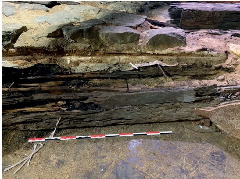
Fig. 86 Pieza de madera desprendida.
