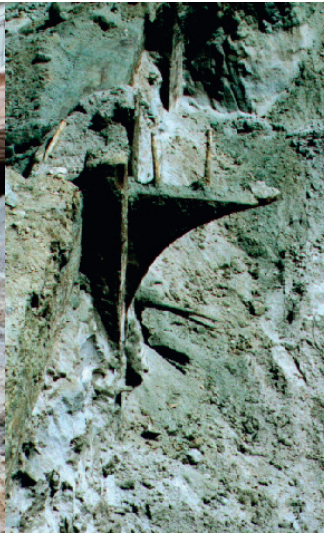
Fig. 21. Detalle de segundo sector del Muelle Esmeralda: escuadra de madera.
