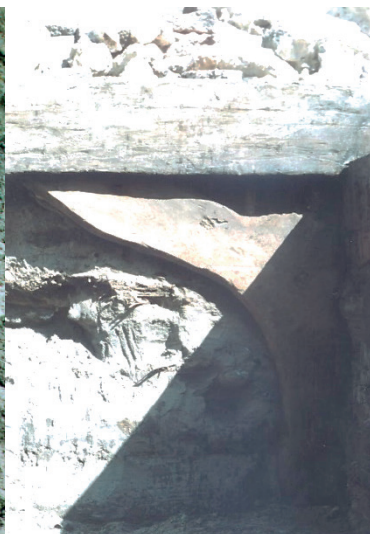
Fig. 37. Detalle de segundo sector del Primer Muelle de Valparaíso o Muelle Esmeralda: escuadra de madera.
