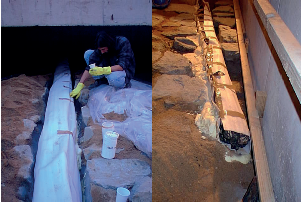
Fig. 59 y 60. Reubicación de los maderos sobre una cama de polímero aislado por una lámina de espuma porosa.
