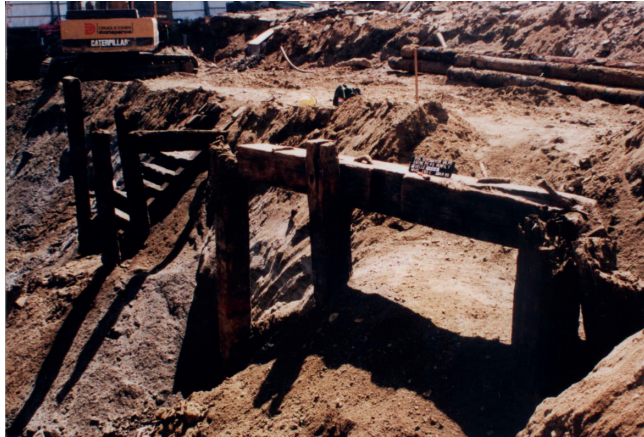
Fig. 23. Vista del tercer sector del Muelle Esmeralda.
