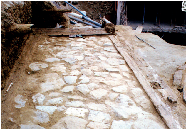
Fig. 15. Otra vista del piso de piedras canteadas y maderos curvos del Muelle Esmeralda.
