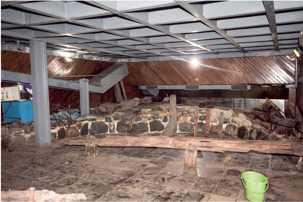
Figura 13: Vista hacia sector norte, es posible apreciar suciedad de origen antrópico y cómo la puerta hidráulica es soportada por un elemento que pertenece a los vestigios del muelle.
