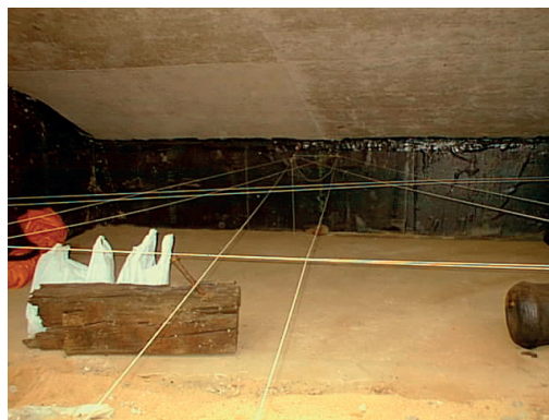
Fig. 56. Trazado con lienzas de la punta del muelle para recolocar las piezas a partir de los dibujos de planta.
