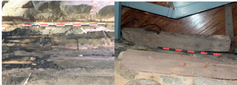
Fig. 67 y 68. Desprendimiento y traslado de piezas de madera.
