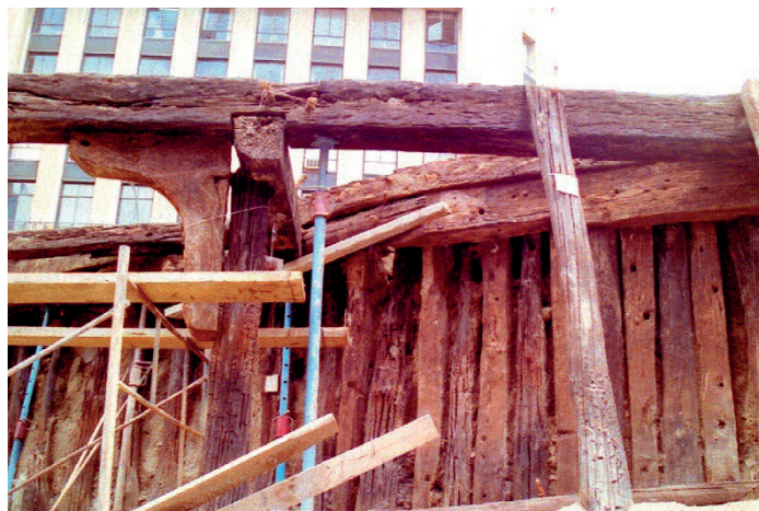
Fig. 30. Vista lateral de la cabeza del Primer Muelle de Valparaíso o Muelle Esmeralda. Se observa la presencia de escuadras y cintas.
