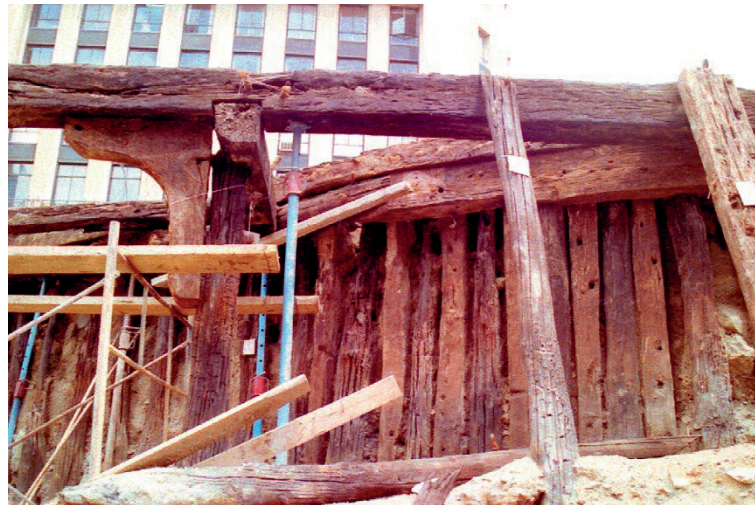
Fig. 16. Vista lateral de la cabeza del Muelle Esmeralda. Se observa la presencia de escuadras y cintas.
