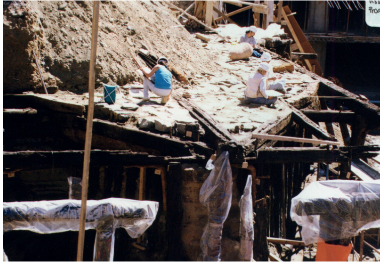
Fig. 27. Sector 1 del Primer Muelle de Valparaíso o Muelle Esmeralda: cabeza de muelle.
