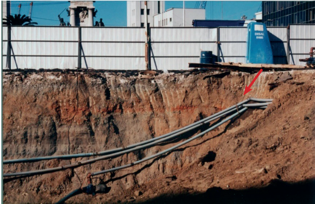
Fig.20. Vista del perfil Y del Paño 1. La flecha roja indica la presencia de maderos.
