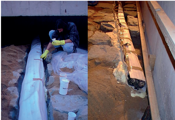
Fig. 44-45. Reubicación de los maderos sobre una cama de polímero aislado por una lámina de espuma porosa.
