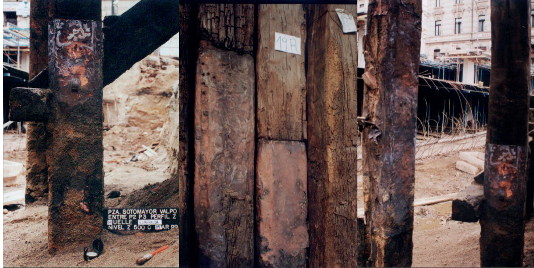
Fig. 42- 43- 44. Detalle de los maderos recubiertos en cobre del tercer sector del Primer Muelle de Valparaíso o Muelle Esmeralda.
