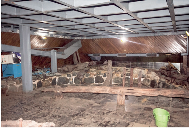
Fig. 49. Vista hacia sector norte, desde donde es posible apreciar suciedad de origen antrópico y como la puerta hidráulica es soportada por un elemento que pertenece a los vestigios del muelle.
