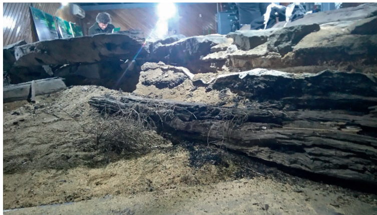
Fig. 67. Vista del Museo de Sitio en 2017. Deterioro lateral de la cabeza del muelle. Descomposición avanzada del madero, presencia de elementos exógenos correspondientes a basura.
