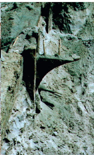
Fig. 36. Detalle de segundo sector del Primer Muelle de Valparaíso o Muelle Esmeralda: escuadra de madera.
